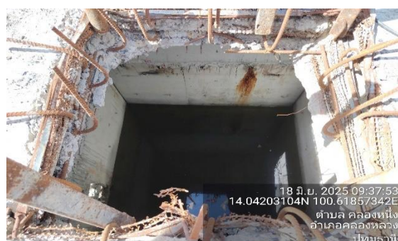
รูปที่ 2-4 รางระบายน้ำ และบ่อดักตะกอน
