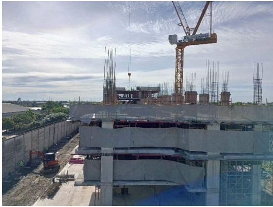
รูปที่ 2-12 การคลุมผ้าใบกันฝุ่นรอบอาคาร
