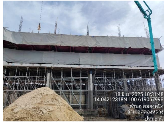
รูปที่ 2-12 การคลุมผ้าใบกันฝุ่นรอบอาคาร
